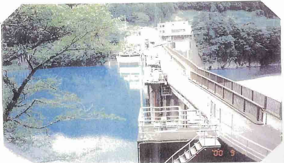
ダムの下にはサ体 があり久野脇発 電所から送れた 水を右岸に送り 導水管で川口発 電所へ。具水 された水は塩郷 ダムに送られる。
