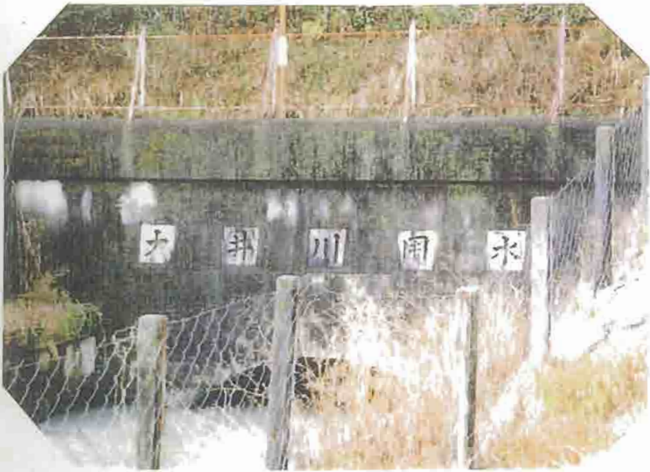
大井川農業用水の 神宮分水工
