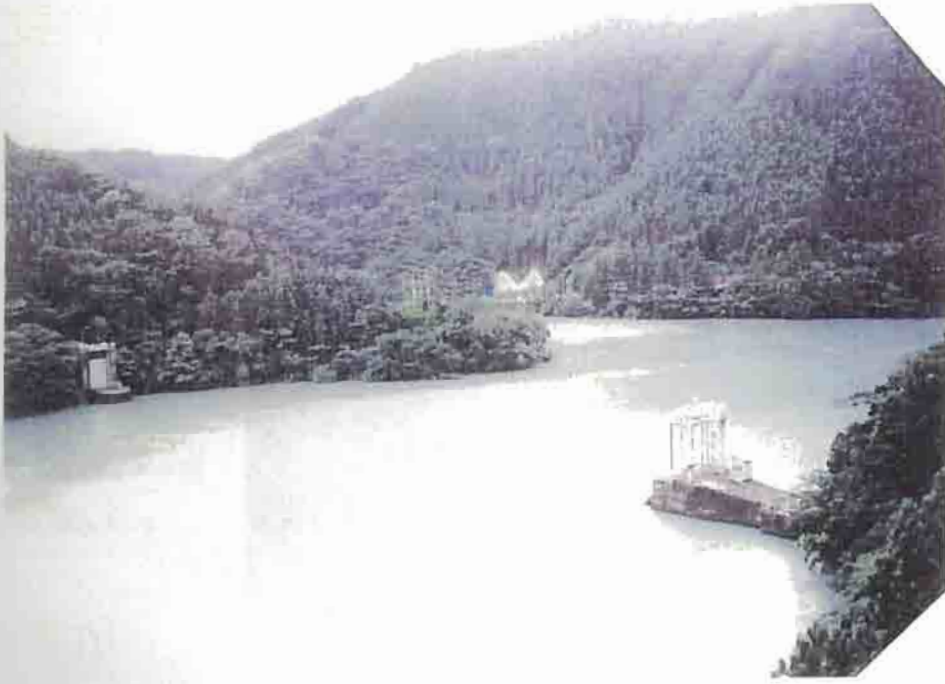
塩郷ダムからの水と 鉦谷川の水を合 せて貯水し、河口発 電所へ送水される。
