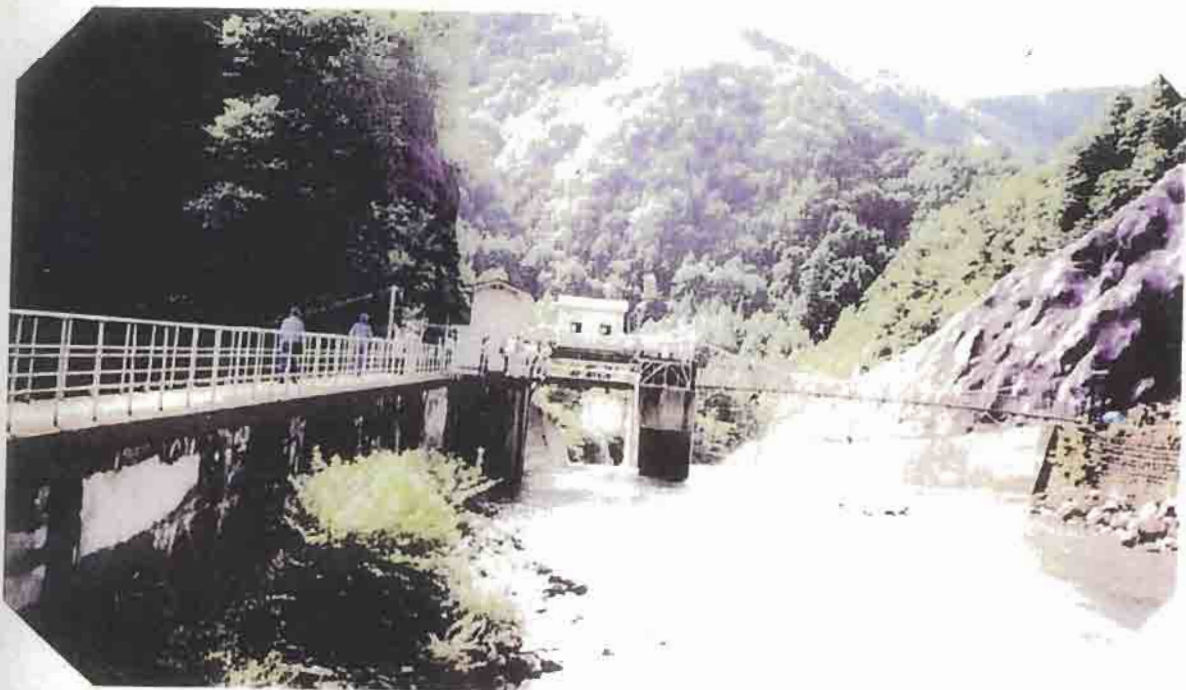
田代ダムの取水口全景
