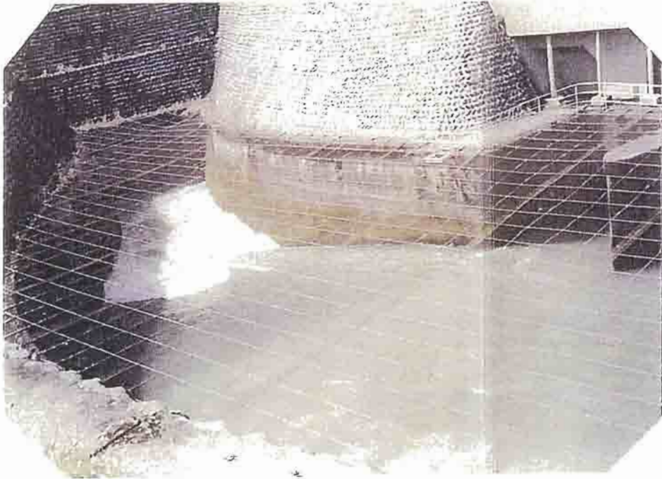
境川ダムから導水管で 送られた水は久野脇発 電所で利水され、送水路 で塩郷ダム下のサ体 へ送られて川底を 昇り送水される。
