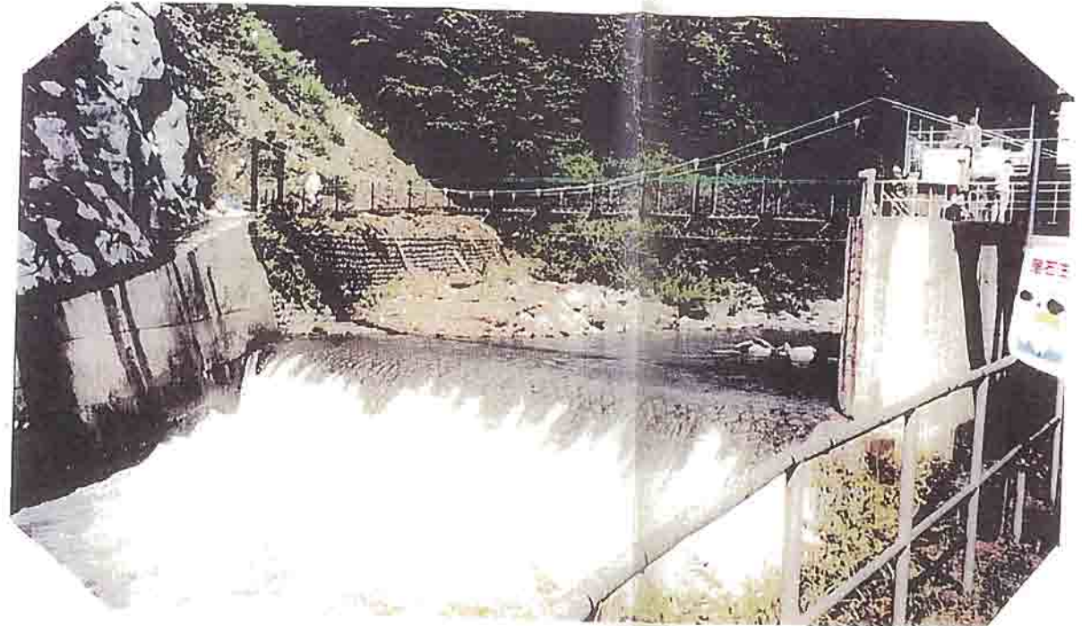
取水口左側の流路 (自然石を敷き詰 めて流路の腐蝕 を防いでいる)
